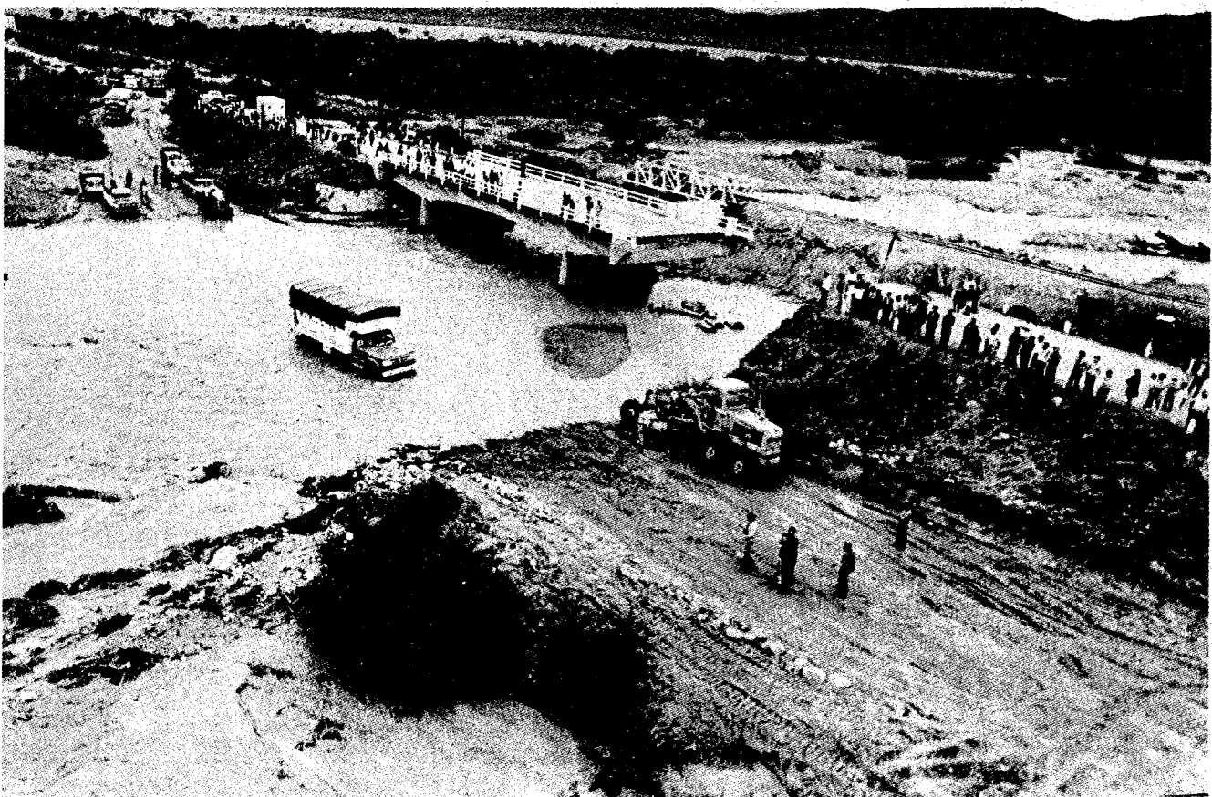
Jujuy: El puente de la ruta 34, sobre el río Negro, parcialmente destruido. Un camion se anima a pasar por un vado
